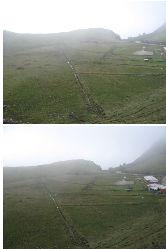
Figura 7. Construcción de zanjas para secar los humedales.
