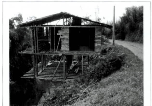
Foto Casa en construcción vereda La Aurora - Manizales.
